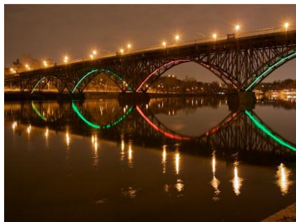
Слика 12. Strawberry Mansion Bridge, Филадельфија
