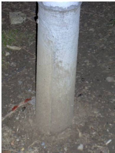
Slika 4. Stub utonuo u zemlju do servisnog otvora
